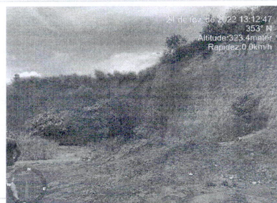
Bota Fora - Coordenadas: 371763.89 E - 9497954.27 S
