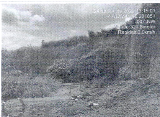
Bota Fora - Coordenadas: 371763.89 E - 9497954.27 S
