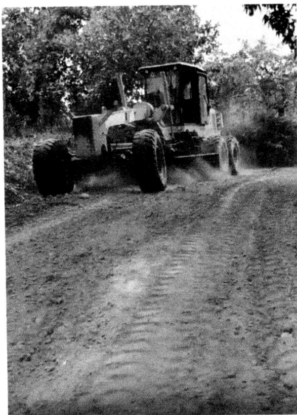
Serviços de regularização e conformação da plataforma.
